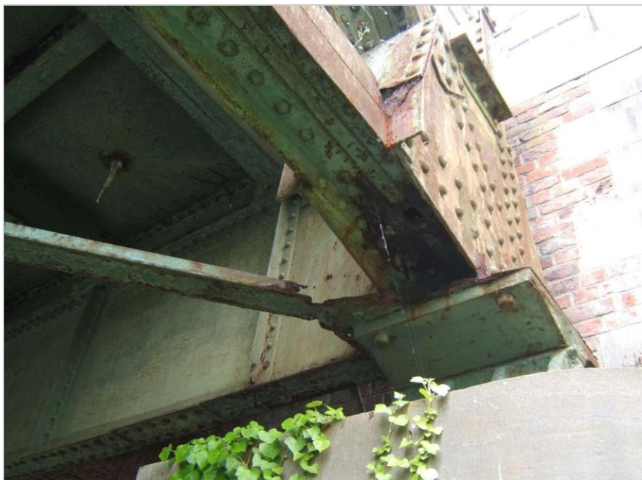
Fig. 9 : Le Pont Royal de 1926 ; dégât du contreventement (photographie extraite du site maubray.be )
