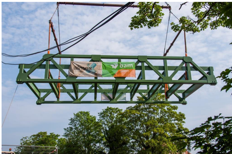
Fig. 11 : Mise en place du nouveau Pont Royal , le 4 juin 2021 (photographie de la Société Almex)
