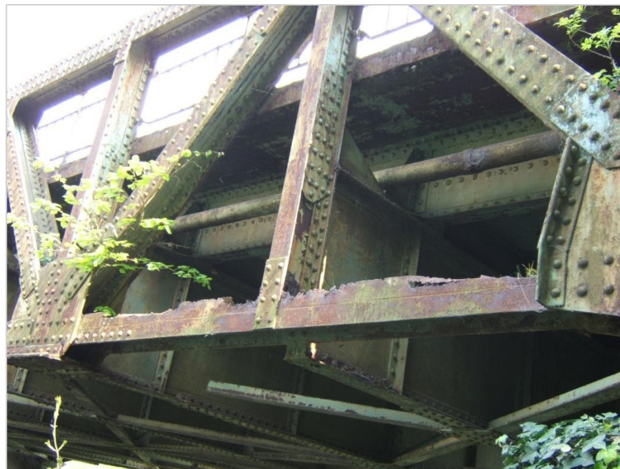
Fig. 10 : Le Pont Royal de 1926 ; dégât de la membrure inférieure (photographie extraite du site maubray.be )
