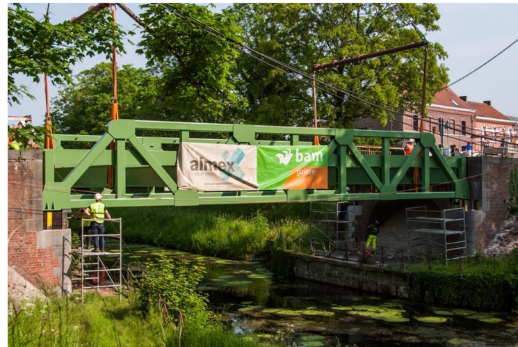
Fig. 12 : Mise en place du nouveau Pont Royal , le 4 juin 2021 (photographie de la Société Almex)
