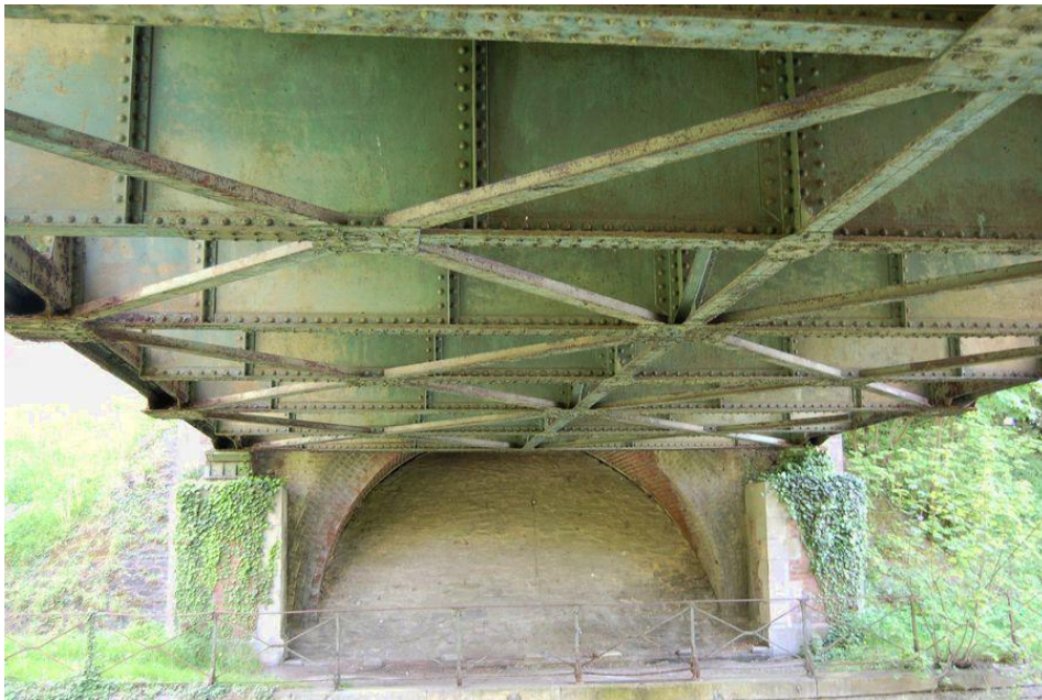
Fig. 8 : Le Pont Royal , vue des traverses et du contreventement (photographie de l'Inventaire du Patrimoine immobilier culturel de Wallonie)
