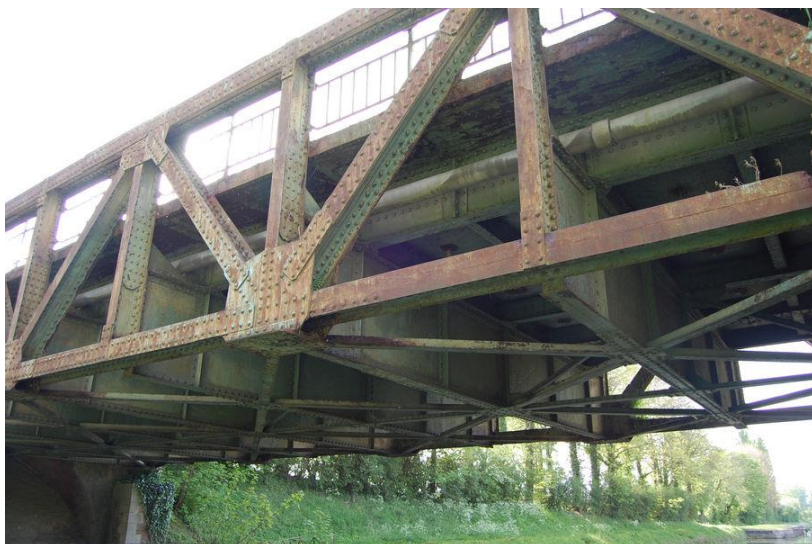
Fig. 5 : Le Pont Royal , détail d'une maîtresse-poutre de rive (photographie de l'Inventaire du patrimoine immob. de Wallonie)
